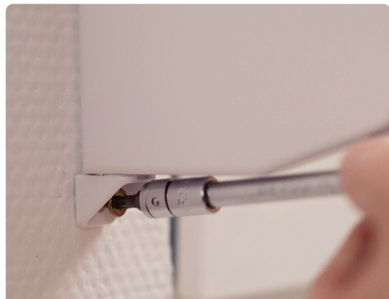
4. Befestigungsschrauben anbringen
