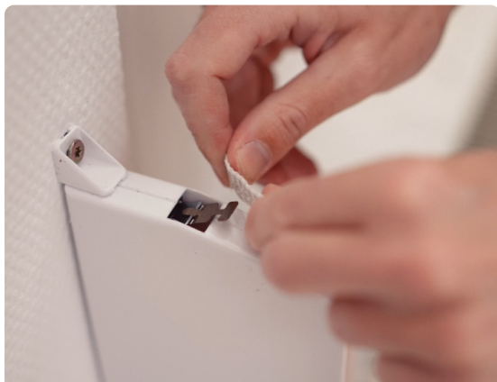
5. Rollladengurt einfädeln
